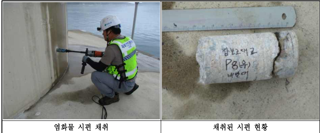
【사진 4.2-3】 염화물 시편 채취 현황
